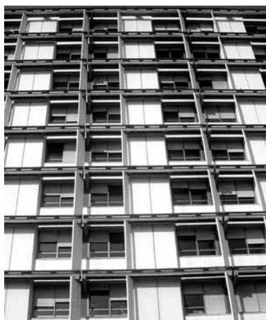
Fig.10 – Detalhe da fachada do hospital
