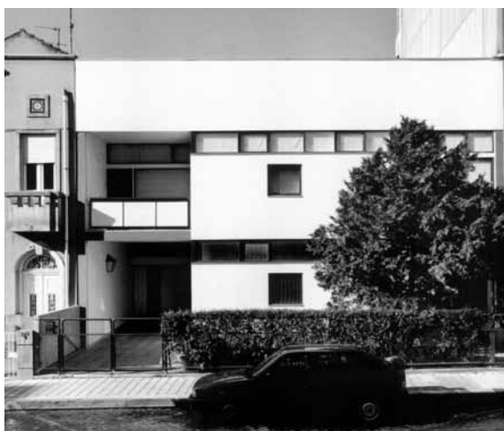
Fig. 3 e 4 – Casa José Braga: perspectiva do exterior [arquivo Celestino de Castro] / fotografia da fachada voltada ao arruamento [Figueira et al., 2001:12]
