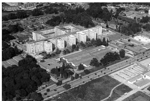
Fig. 8 – vista aérea do Hospital de S. João –
