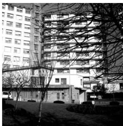
Fig. 14 – imagem dos elementos de fachada
