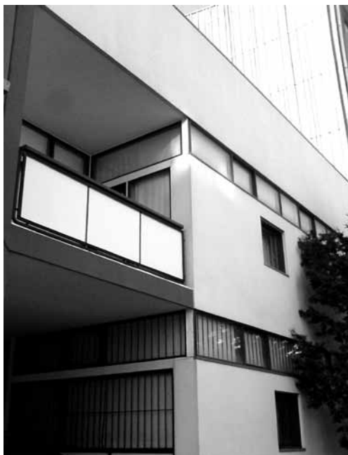
Fig. 5 – Casa em Santos Pousada – Porto
