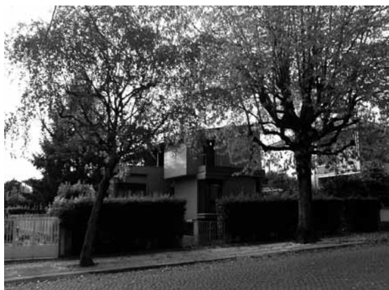
Casa Baltazar de Castro, Fotografia Exterior (Nunes, 2007, pp. 87)
