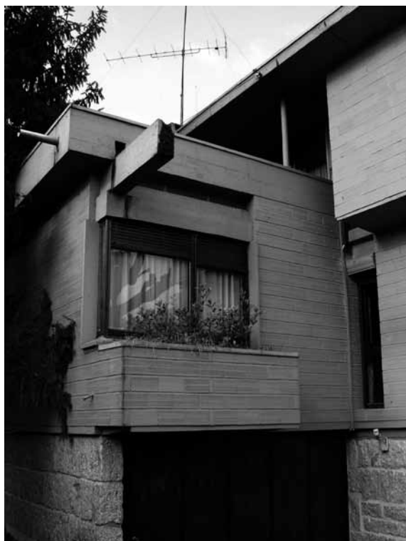
Casa Baltazar de Castro, Fotografia Exterior (Nunes, 2007, pp. 87)
